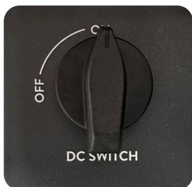
Abbildung 17: Deaktivierung der PV Gleichstromversorgung_1.1
